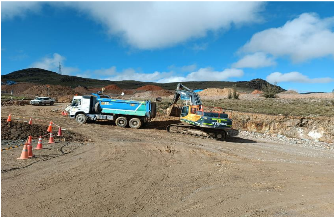
Figura 27: Carguío de material inadecuado con volquetes
