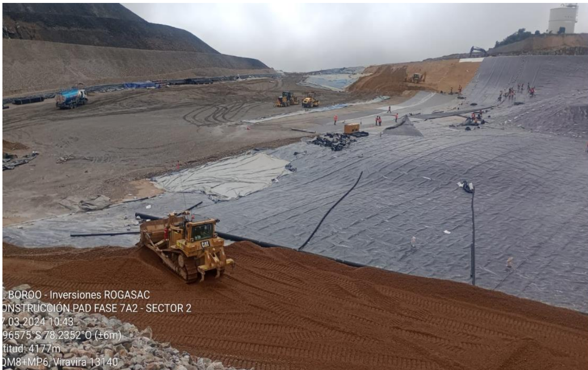
Figura 26: Vista de Tractor D-6, empujando material over liner en área de labor.
