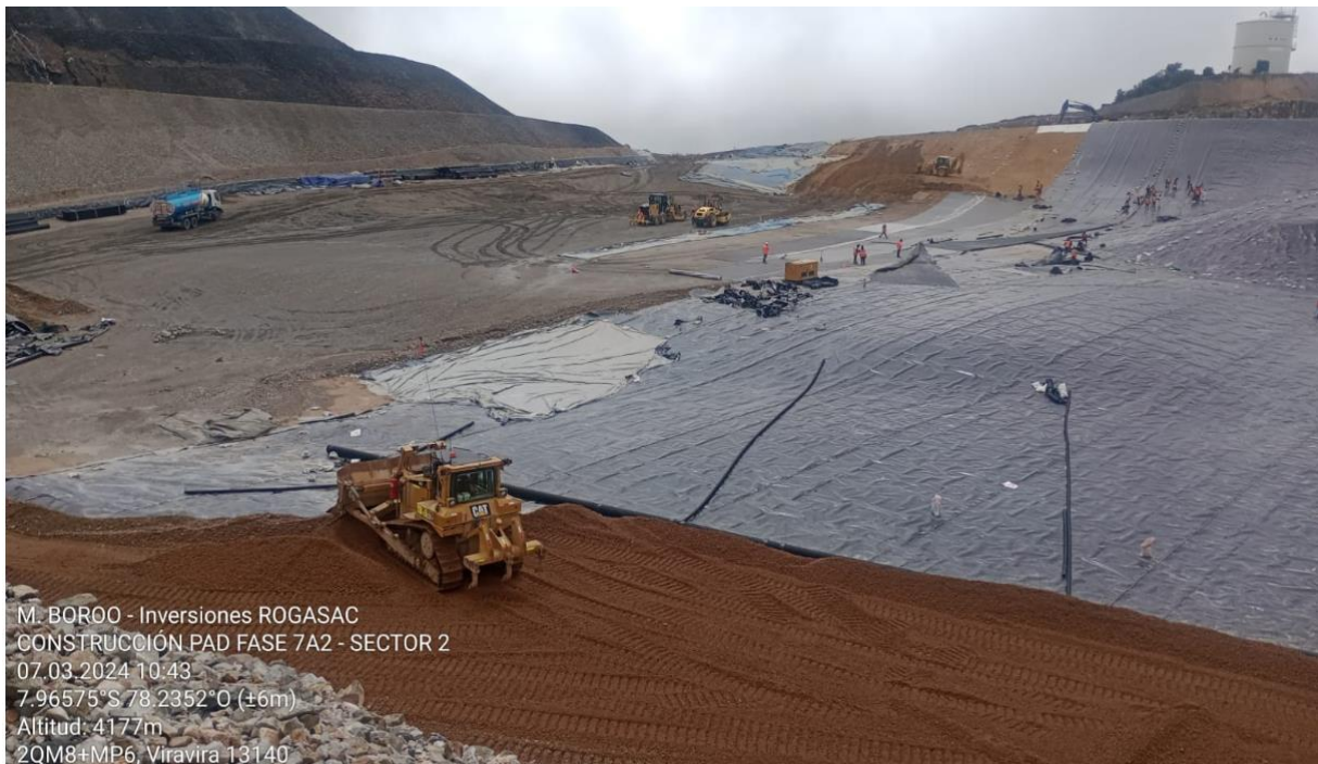
Figura 28: Foto panorámica de la construcción del Pad.
