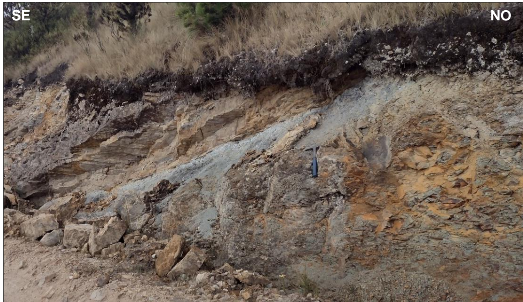
Foto 9. Vista al SO; Formación Carhuaz en el tramo de carretera El Punre-Michiquillay. Coordenadas N- 9222537. E- 799090.
