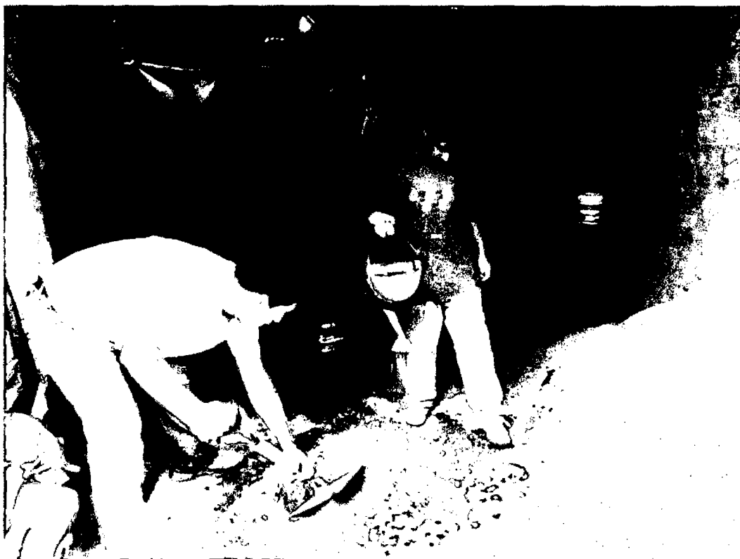
Imagen 3.2. Preparación de la mezcla húmeda de suelo - cemento.
