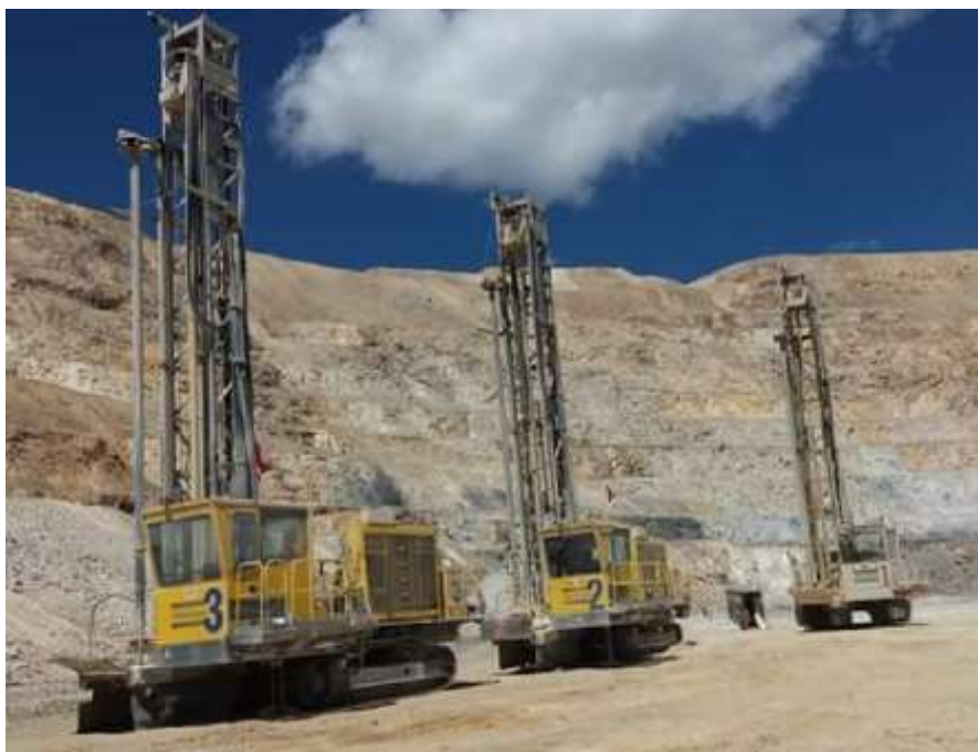
Figura 7. Equipos de perforación en el Tajo Diana, zona de QSD.
