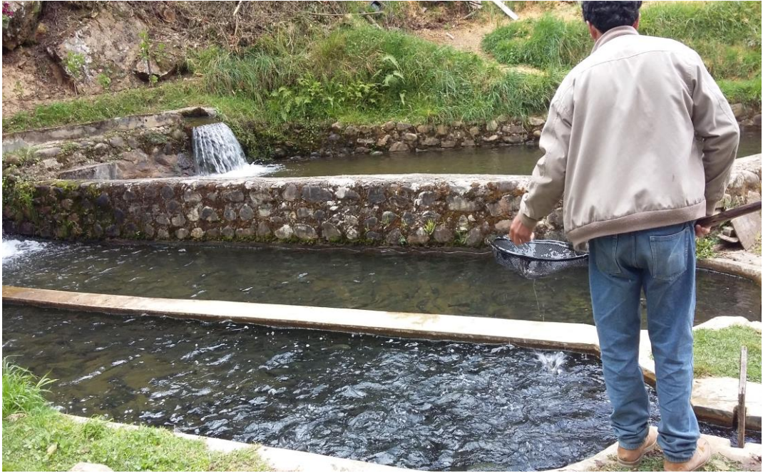
Fig 6. Estanque construido a base de concreto y piedra
