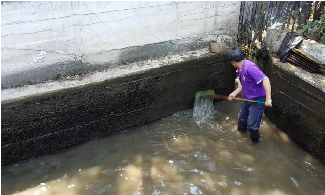
Fig 8. Método de limpieza a base de agua mas escobillado.
