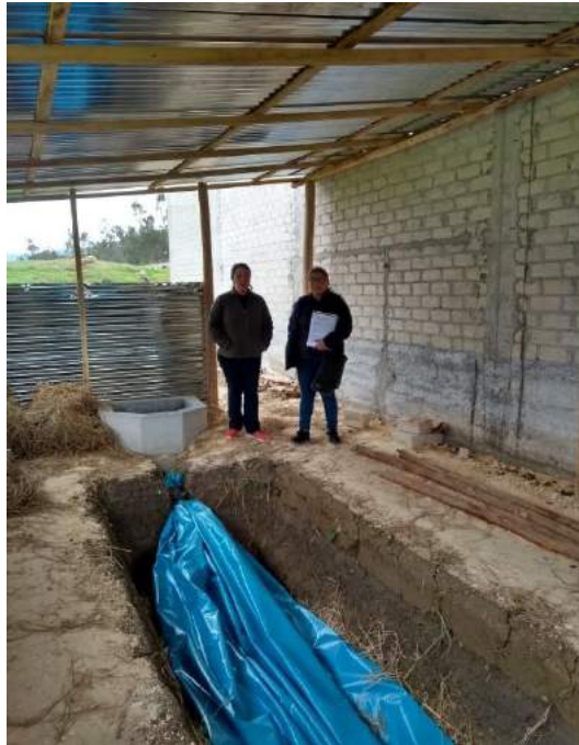
Figura 15. Visita del asesor a las instalaciones del biodigestor
