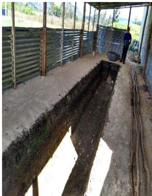
Figura 14. Zanja en forma trapezoidal para encajar el biodigestor
