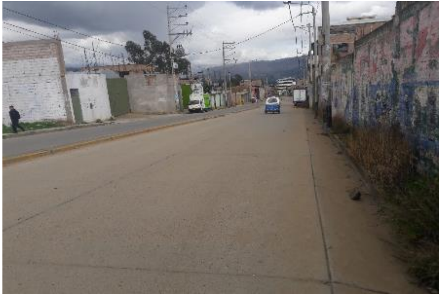
Fotografía N° 14: Falta de vereda en algunos tramos de la Av. Héroes del Cenepa
