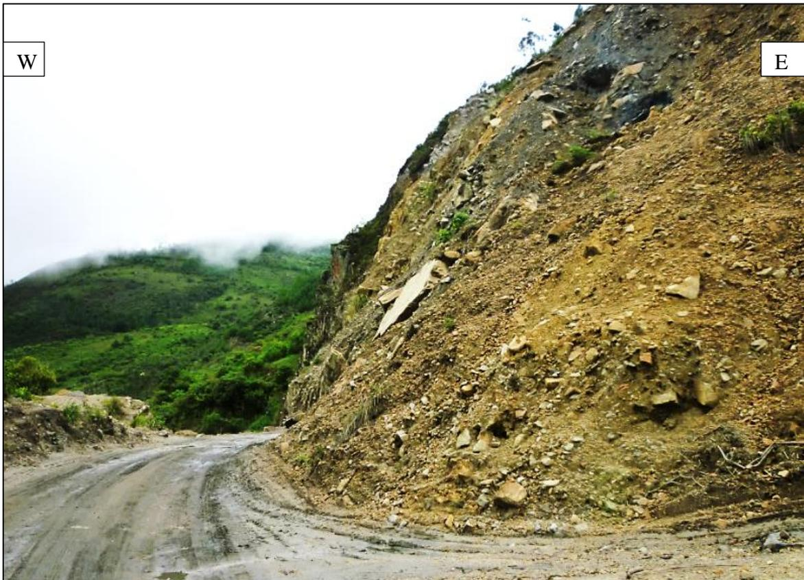
Figura 12 Depósito coluvial en el talud de la carretera (la carretera tiene un ancho de 7m aprox.) en el tramo del Km 14+547 a Km 14+685.
